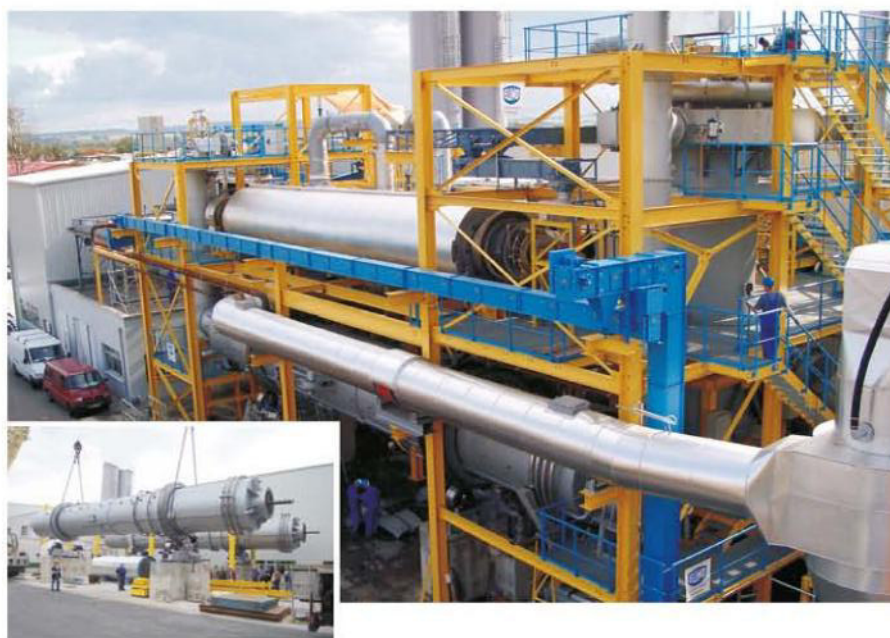
Anlage zur Aktivkohleherstellung in der Montagephase
