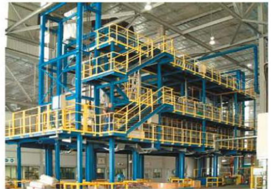
Warmauslagerungslinie in modularem Aufbau mit externer Fördertechnik für Motorblöcke
